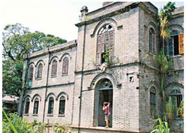
「福州老建築百科」成員池志海在實地拍攝倉山「泛船埔天主教堂神父樓」建築圖。 圖片由受訪者提供
